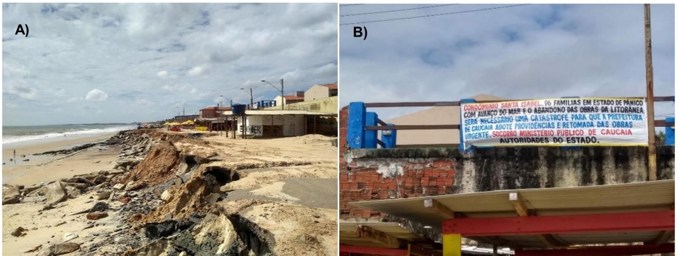
**Figura 4.** A) Figura referente à destruição de parte da via costeira pelo avanço do mar e à ameaça aos condomínios logo a seguir. B) Reivindicação dos moradores locais em face ao risco eminente de colapso das suas propriedades pelo avanço do mar.
