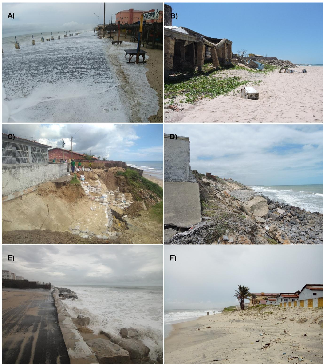
**Figura 7.** Formas de ocupação ao longo da frente marinha do Icarai e problemas associados à erosão costeira e pluvial e à inundação marinha.
